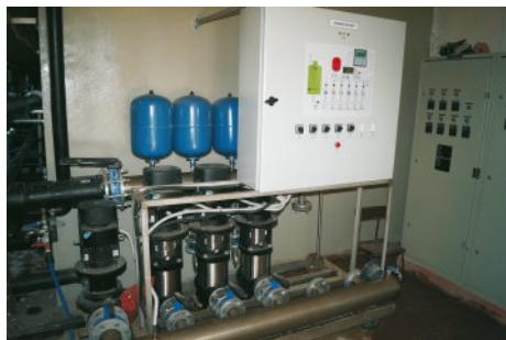
Zbiorniki ciśnieniowe z szafą sterowniczą
